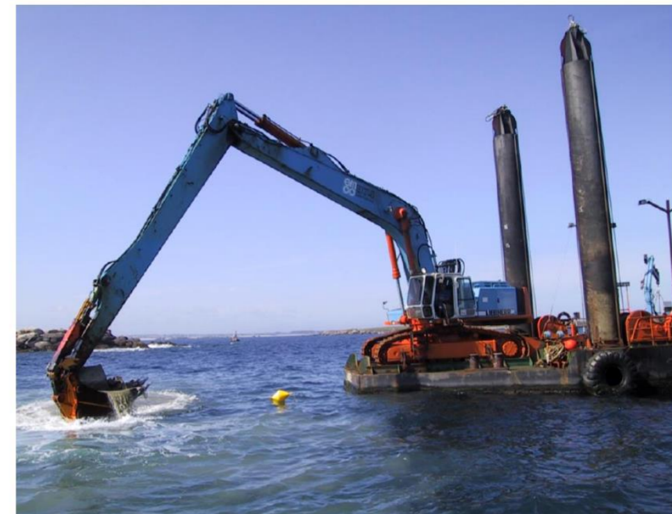
Figure 26 : Pelle mécanique sur ponton flottant
