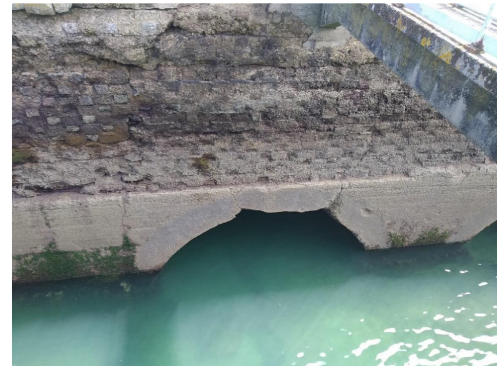
Figure 44 : Délimitation du terre-plein au niveau de la jetée Sud
